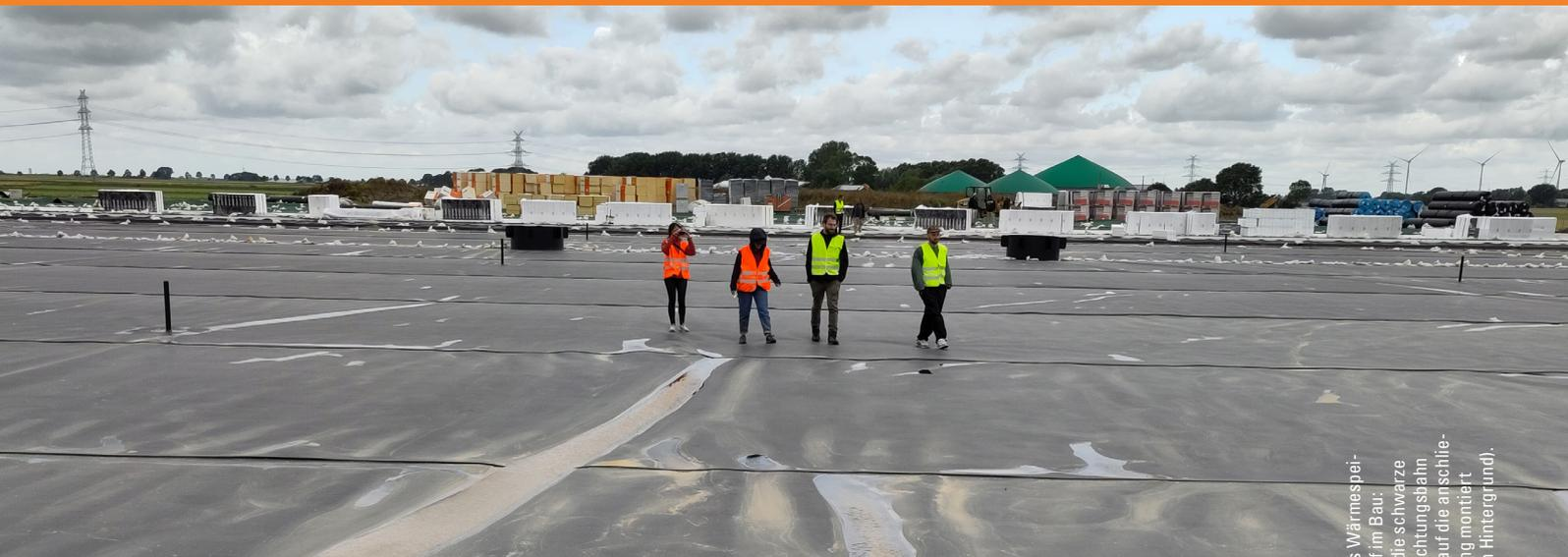
Begehung des Wärmespeichers Meidorf im Bau: Zu sehen ist die schwarze Kunststoff-Dichtungsbahn des Deckels, auf die anschließend Dämmung montiert wird (weiß im Hintergrund).
