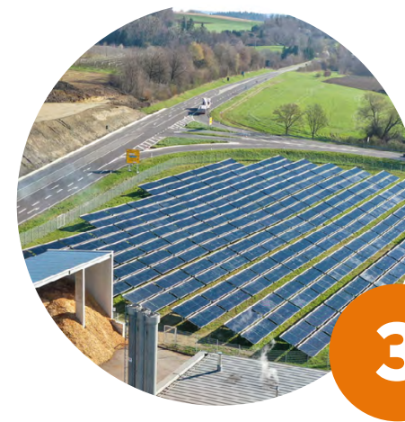
Solarthermieranlage in Überlingen-Schättlisberg
