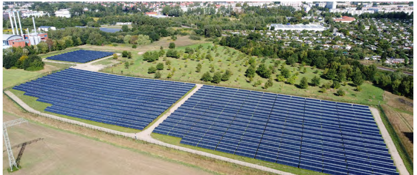
Blick auf die Freiflächen-Solarthermieanlage in Greifswald (Stadtwerke Greifswald GmbH)
