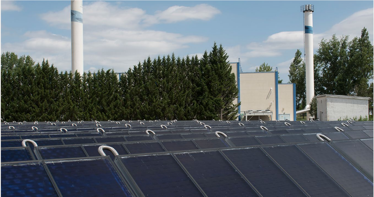
In Bernburg befinden sich die beiden Solarthermiefelder in idealer Nähe zum Heizkraftwerk. Früher wurde auf der Fläche
