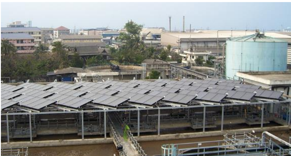
Abbildung 2-27: Solarkollektoranlage bei einem fischverarbeitenden Betrieb in Thailand (Foto: Arcon Sunmark)
