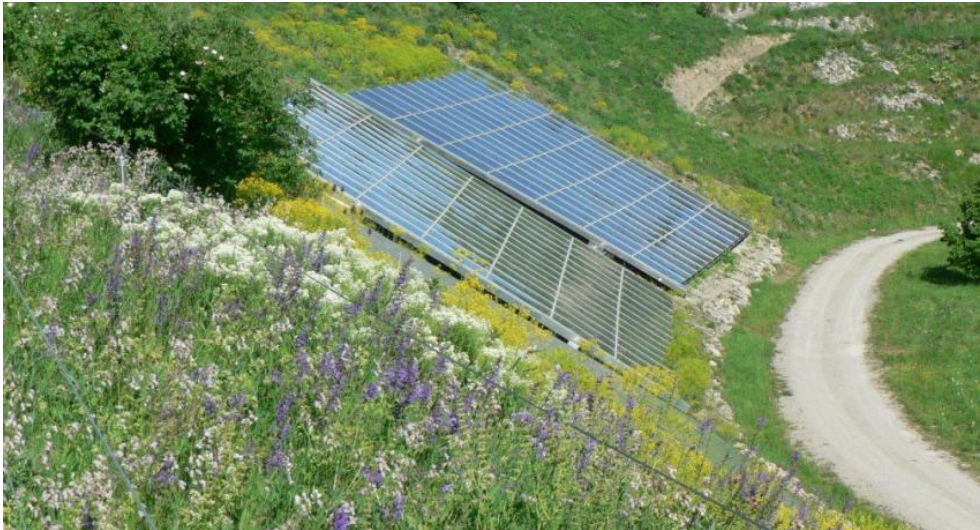
Abbildung 2-30: Lärmschutzwall mit Solarkollektoren in Crailsheim (Foto: Lorinser)
