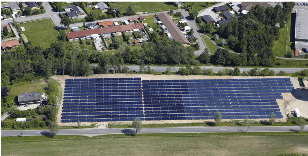
Abbildung 2-23: Solarkollektoranlage zwischen zwei Straßen in Helsingør (Foto: Arcon Sunmark)
