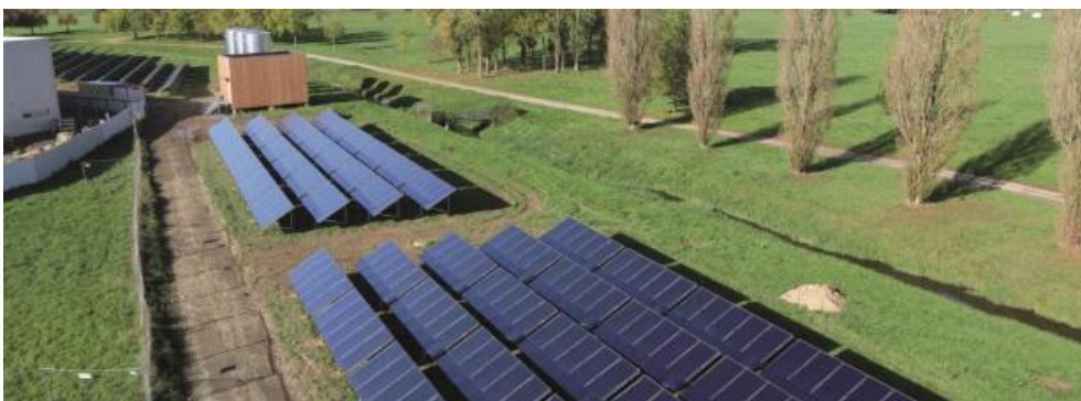
Abbildung 2-21: Solaranlage auf einer Überflutungsfläche in Châteaubriant
