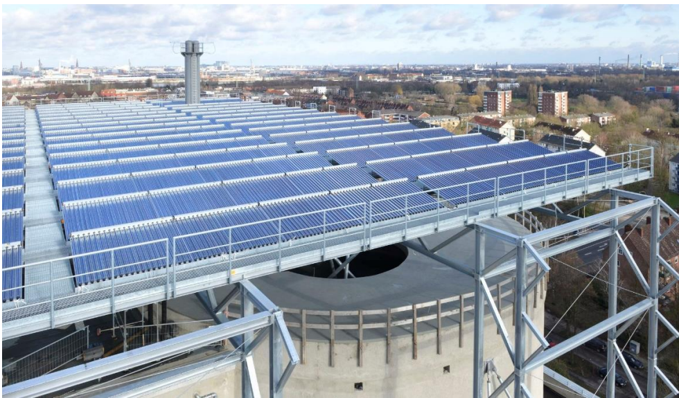
Abbildung 2-28: Solarkollektoranlage auf dem Energiebunker Hamburg (Foto: Ritter XL Solar)
