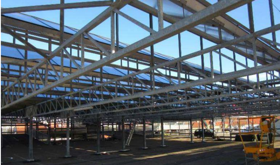
Abbildung 2-26: Solaranlage auf einem Parkdeck in Graz (Foto: Solid)
