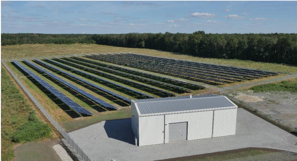
Abbildung 2-15: Solaranlage in Senftenberg (Foto: Ritter XL Solar)
