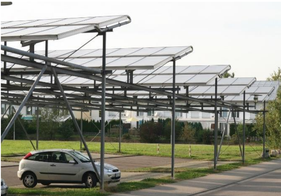
Abbildung 2-25: Kollektoranlage als Parkplatzüberdachung in Neckarsulm (Foto: Solites)
