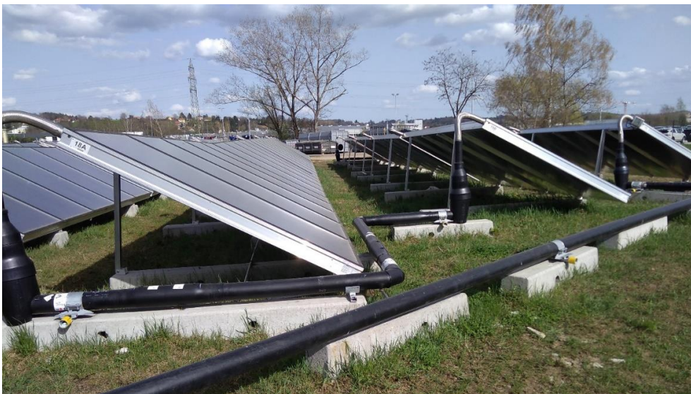
Abbildung 2-16: Freiflächen-Solaranlage in Graz (Foto: Hamburg Institut)
