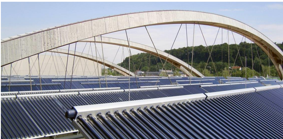
Abbildung 2-29: Solarkollektoranlage auf der Messehalle in Wels, Österreich (Foto: Ritter XL Solar)
