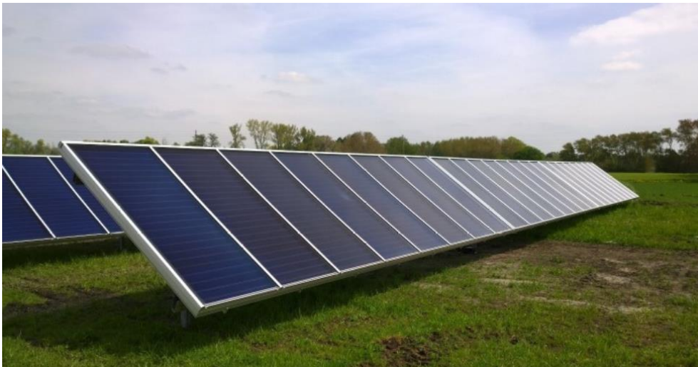
Abbildung 2-12: Freiflächenanlage für Prozesswärme in Bohlingen (Quelle (Energieportal24, 2016))
