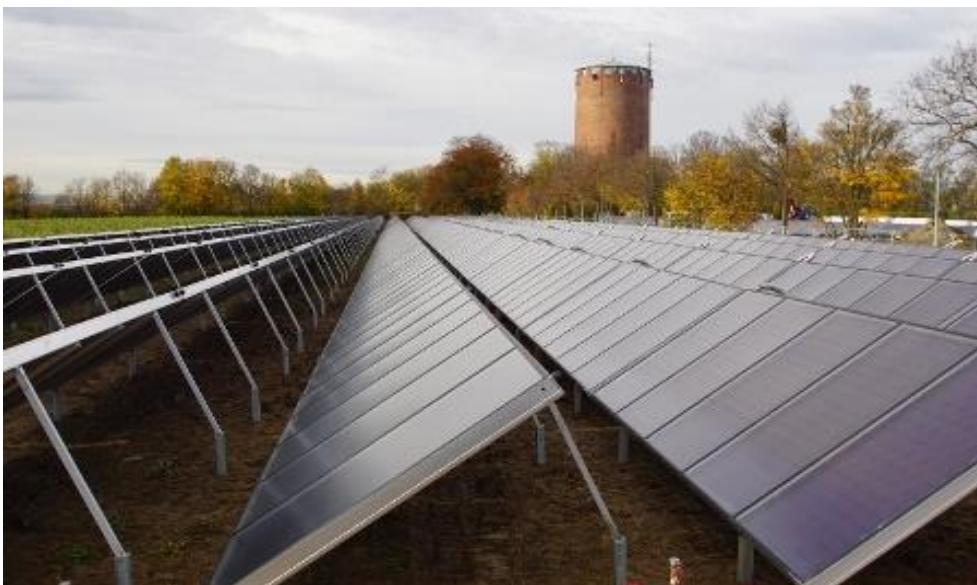
Abbildung 2-14: Neu errichtetes Solarthermiekollektorfeld am Römerhügel (Foto: Stadtwerke Ludwigsburg-Kornwestheim)
