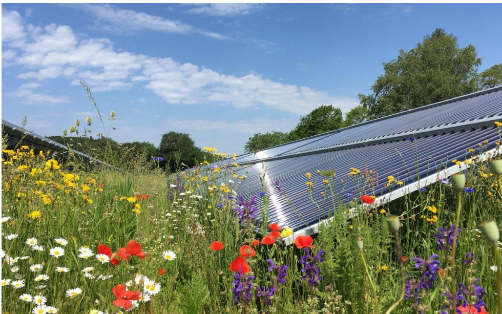
Abbildung 2-31: Solarkollektoranlage in Randegg (Foto: Solites)
