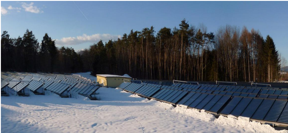
Abbildung 2-20: Solarthermische Anlage am Wasserwerk Andritz bei Graz (Foto: SOLID)
