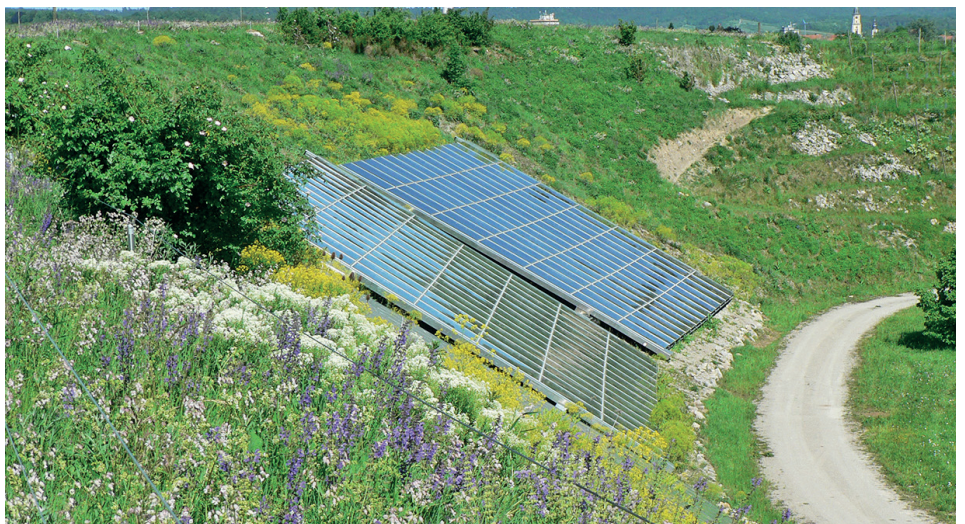
Die hohen Lärmschutzwälle in Crailsheim bieten ausreichend Fläche und eine Neigung, die dem optimalen Aufstellwinkel der Großkollektoren entspricht. (Foto: Bruno Lorinser)
