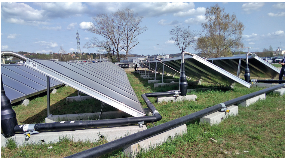
Freiflächen-Solarthermieanlage auf ehemaliger Hausmülldeponie in Graz. (Foto: Hamburg Institut)
