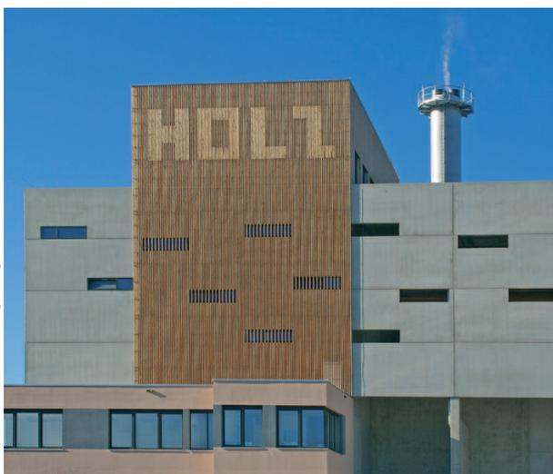
Seit 2010 wird das Ludwigsburger Fernwärmenetz zu etwa 70 Prozent von einem Holzheizkraftwerk mit ORC-Modul zur Stromerzeugung befeuert. Bald soll auch die bislang wohl größte Solarthermieanlage Deutschlands einen Beitrag leisten.
