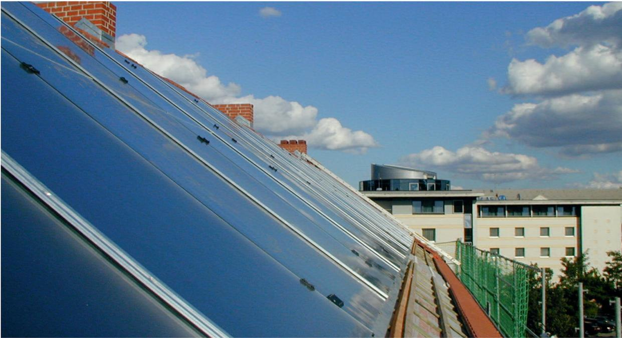
Von den Dächern des Cohn'schen Viertels speisen schon seit 18 Jahren Solarkollektoren Energie ins Fernwärmenetz ein.
