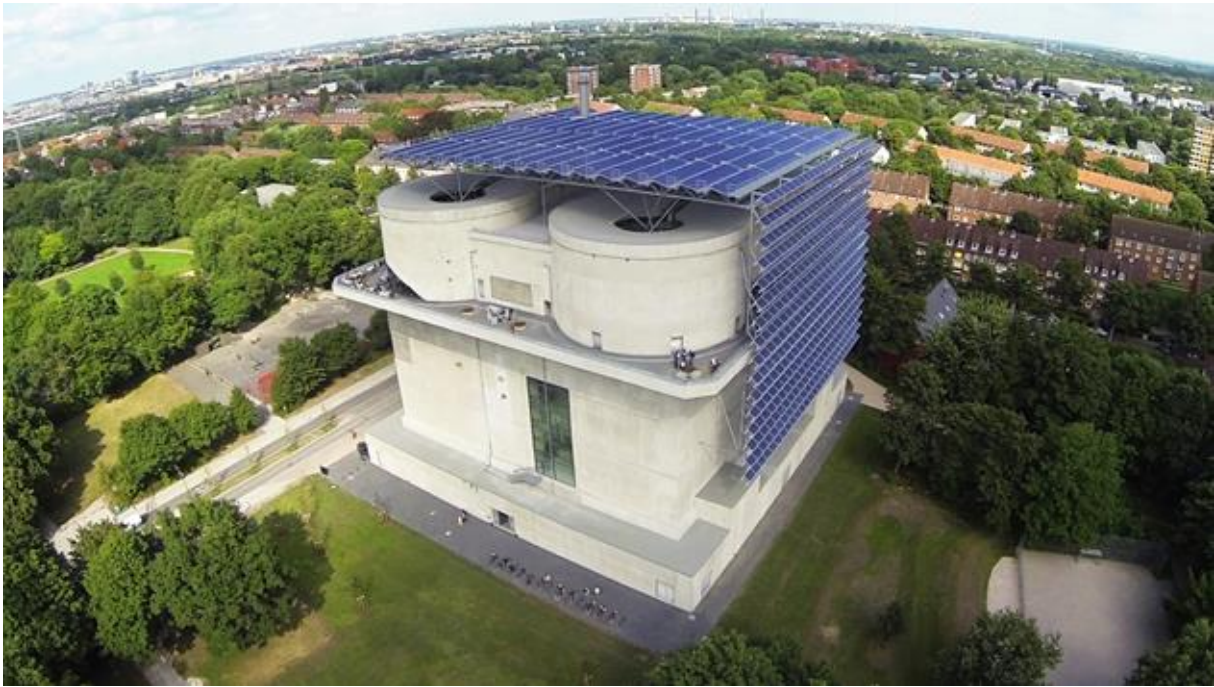
Abbildung 8: Der 2013 fertiggestellte Energiebunker in Hamburg-Wilhelmsburg (Quelle: Hamburg Energie).
