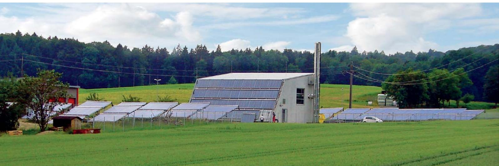
In Büsingen liefern großflächige Vakuumröhrenkollektoren mit einer Fläche von 1.090 m<sup>2</sup> die gesamte Wärme, die im Sommer im Wärmenetz benötigt wird. Dadurch wird ein unwirtschaftlicher Teillastbetrieb der Biomasseheizkessel vermieden. Das im Jahr 2013 in Betrieb genommene Wärmenetz versorgt über 100 Gebäude mit Wärme aus regenerativen Energiequellen. Dieses Konzept ist zukunftsweisend und auf neu entstehende Bioenergiedörfer übertragbar.
