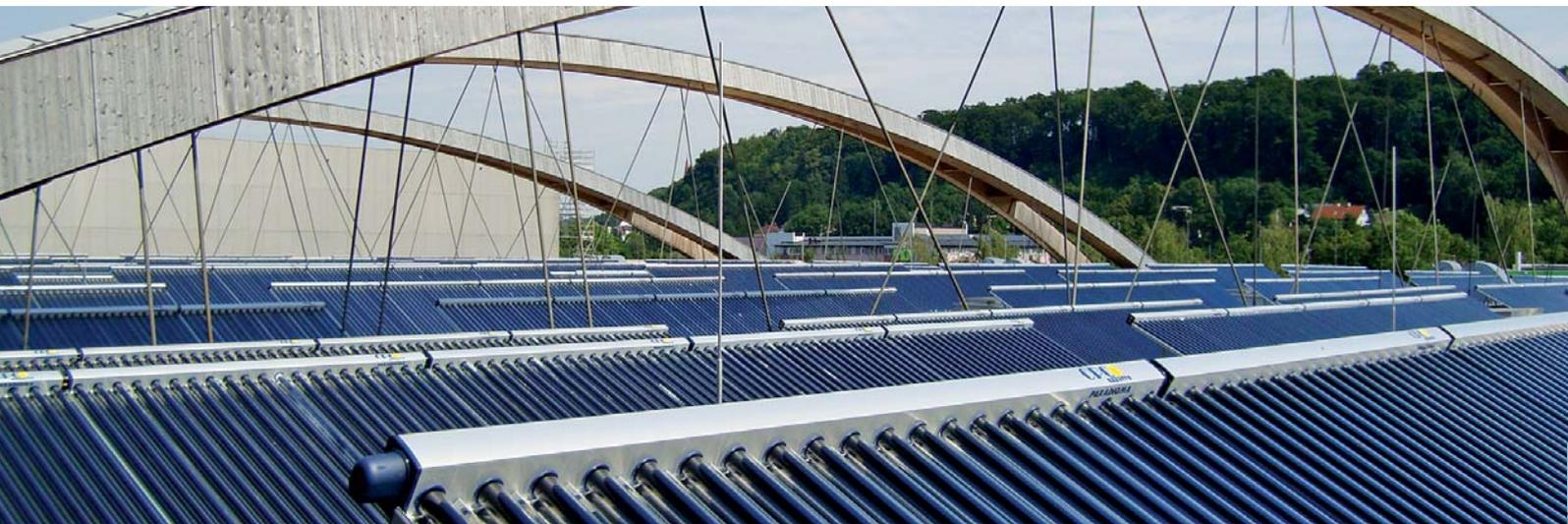
Im Mai 2011 ging dann die Solaranlage mit einer Größe von ca. 3.400 m<sup>2</sup> bzw. 2,4 Megawatt thermischer Leistung in Betrieb. Die Anlage ist dezentral in das Fernwärmenetz der Stadt Wels eingebunden. Dieses hat einen jährlichen Wärmebedarf von ungefähr 173 GWh, der im Wesentlichen durch ein Fernheizkraftwerk (Erdgas) und eine KWK-basierte Müllverbrennungsanlage gedeckt wird.
