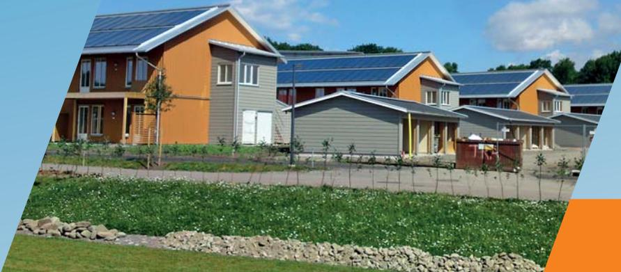
Dieses 2013 erschlossene Wohngebiet wird zentral über ein Nahwärmesystem mit einem Biomasseheizwerk und 680 m<sup>2</sup> dachintegrierten Kollektoren versorgt. Alle Gebäude wurden nach hohen Energiestandards gebaut und haben einen sehr niedrigen spezifischen Wärmebedarf. Dennoch ist die zentrale Wärmeversorgung eine erfolgreiche Lösung und ermöglicht eine effiziente Nutzung von erneuerbare Energien.
