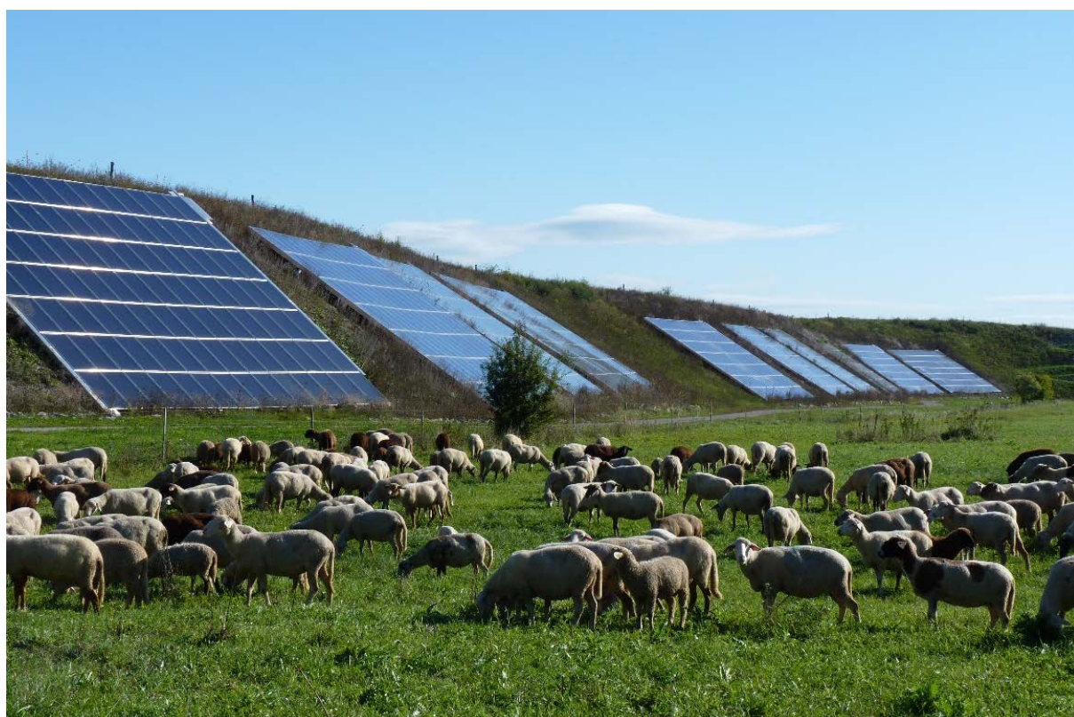
Foto: Bruno Lorinser – Solarthermie-Anlage in Crailsheim
