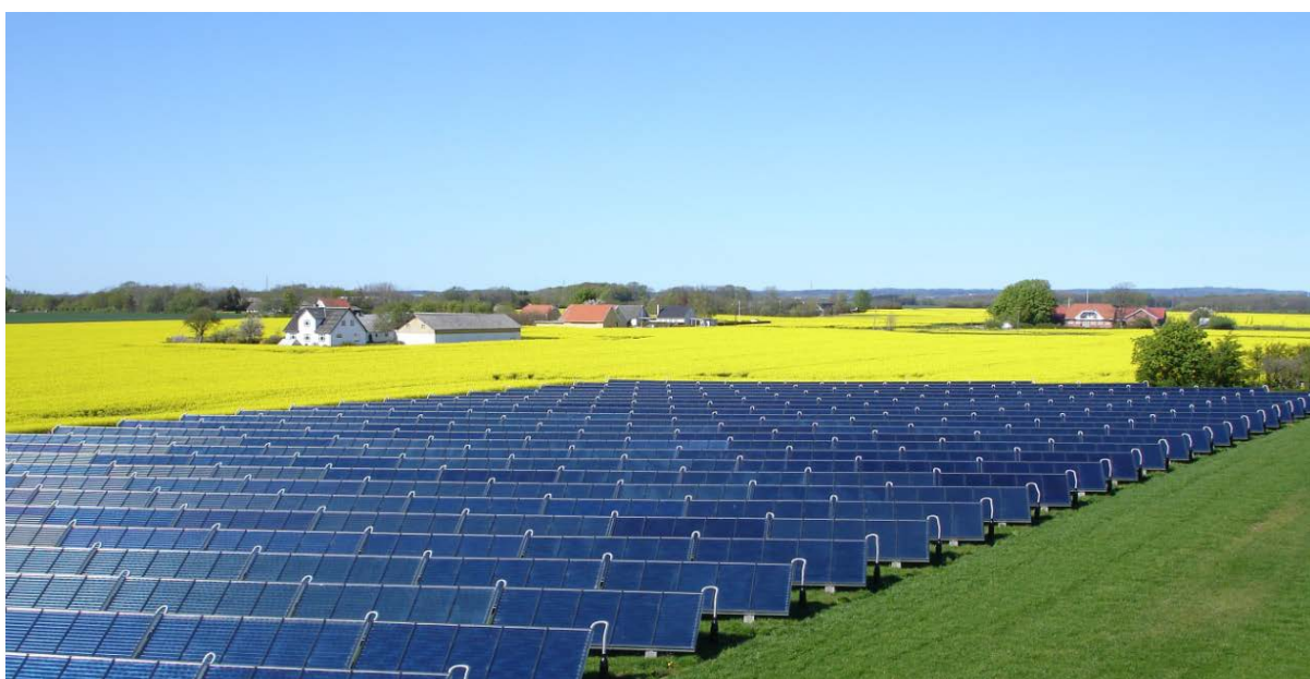
Foto: Arcon-Sunmark – Solarthermische Großanlage in Ulsted, Dänemark
