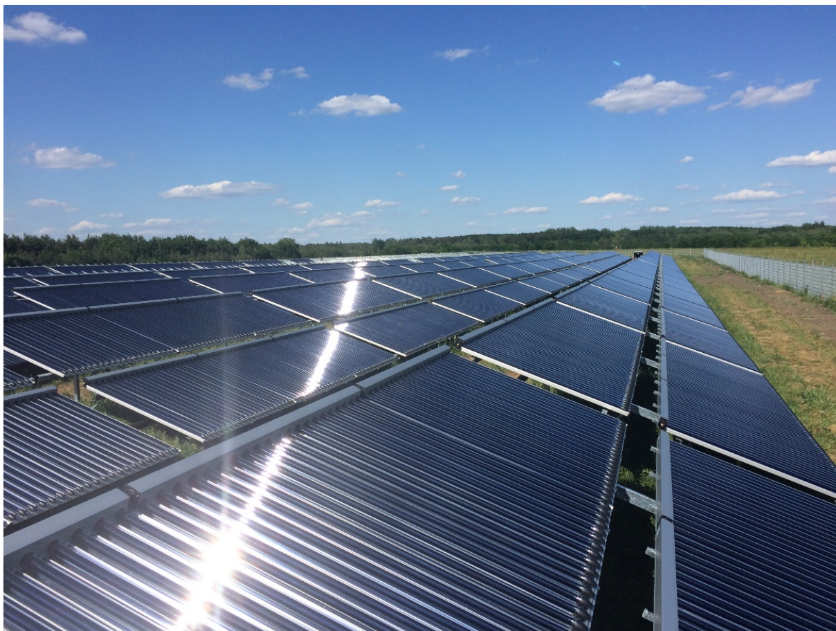
Foto: Ritter XL Solar GmbH – Juni 2016 Bau Deutschlands größter Anlage in Senftenberg mit 8.300 m 2 Kollektorfläche
