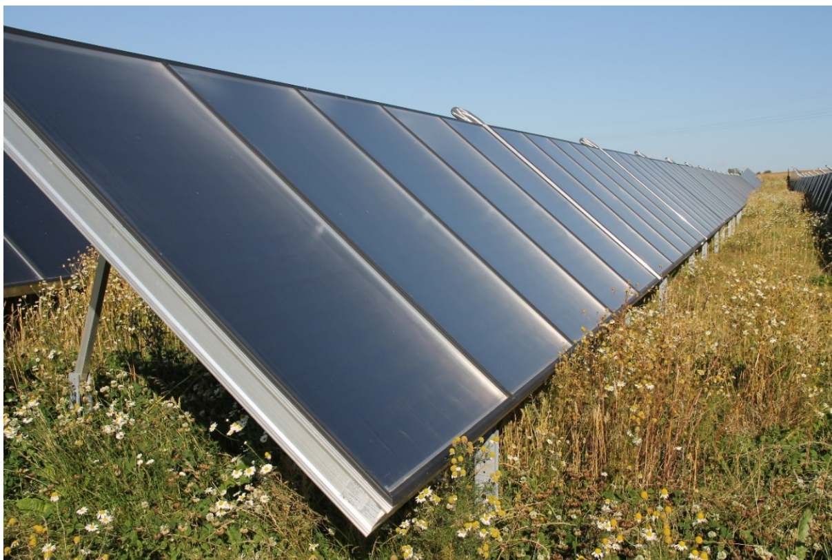
Foto: Dr. Matthias Sandrock – Freiflächen-Solarthermie-Anlage Snedsted, Dänemark
