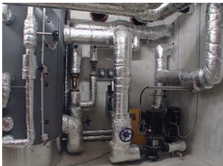
Einbindung der Solarthermieanlage in das Fernwärmenetz
