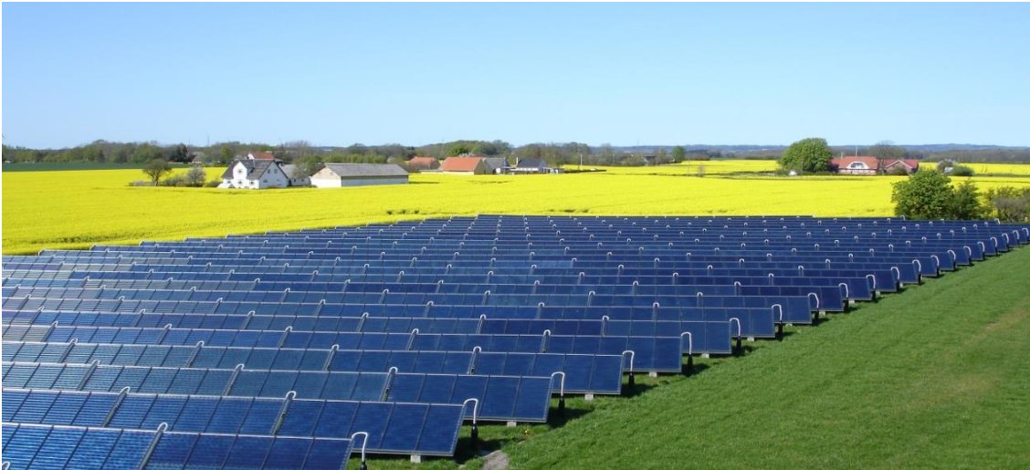
Abbildung 1: Solarthermische Großanlage in Ulsted, Dänemark (Quelle: Arcon)
