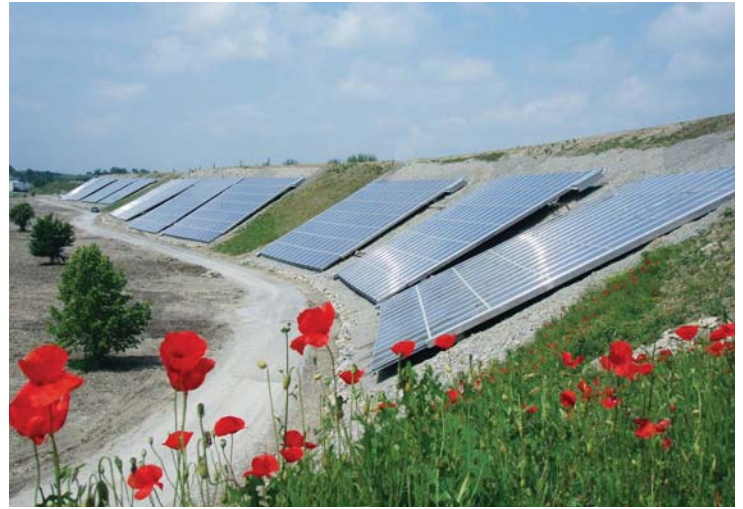
Solarkollektoren auf dem Lärmschutzwall
