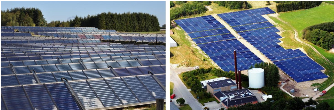
Abbildung 11: 18.000 m 2 Kollektorfläche des Systems in Braedstrup (DK) (Quelle: Solites, Braedstrup Fjernvarme)
