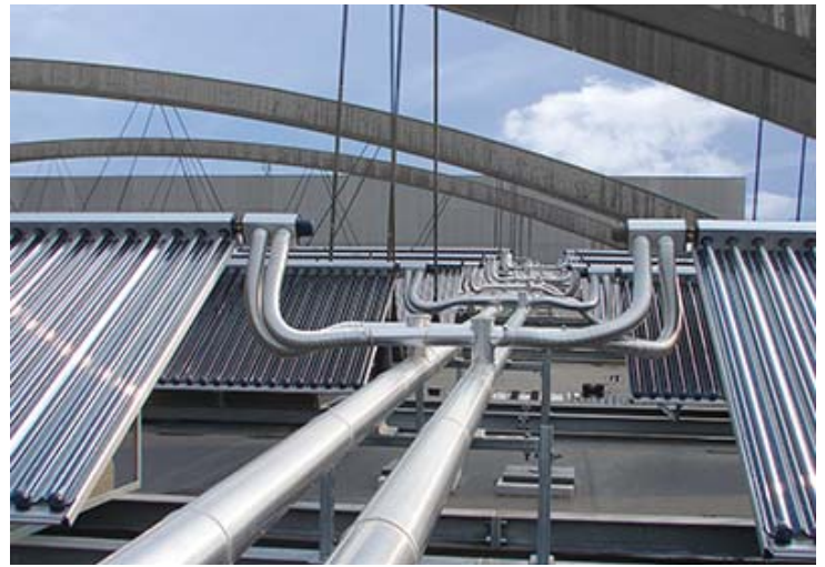
Verrohrung der Solarkollektoren auf dem Messedach
