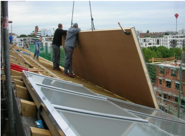
Abbildung 7: Dachintegrierte Solarkollektoren auf Mehrfamilienhäusern (linkes Bild, Quelle: Solites); Solare Nahwärme Stuttgart Burgholzof (rechtes Bild, Quelle: EnBW Energie Baden-Württemberg AG)
