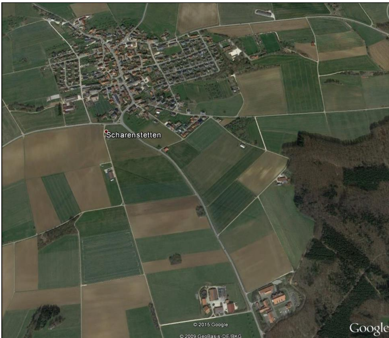
Abbildung 50: Luftbild von Scharenstetten mit der Gasverdichterstation am unteren Bildrand rechts. Quelle: Google Earth.
