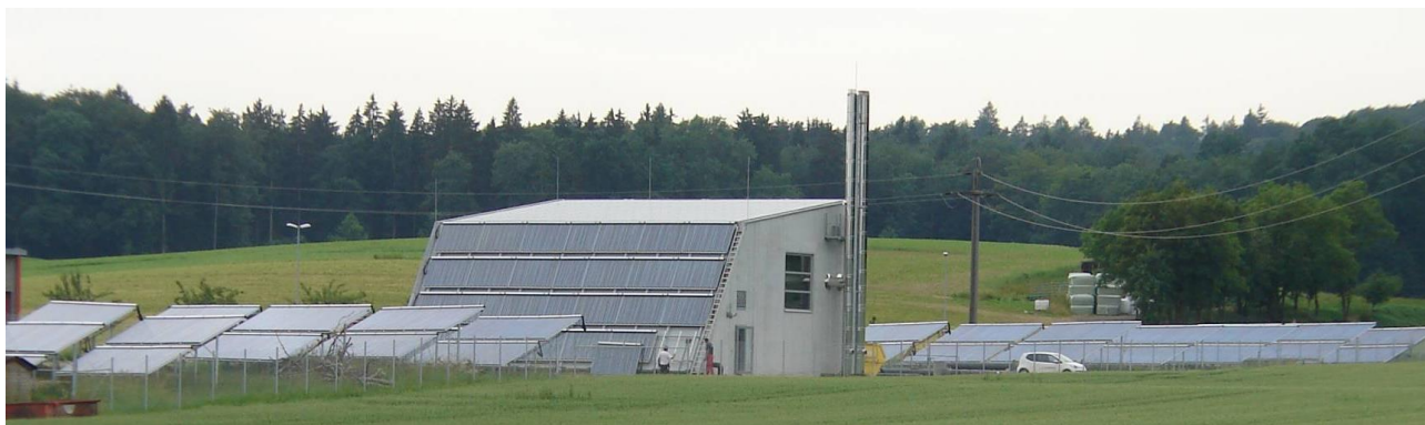
Abbildung 4: Heizwerk des Bioenergiedorfs Büsingen mit 1.090 m 2 Vakuumröhrenkollektoren und einem Biomassekessel (Quelle: Ritter XL Solar GmbH)
