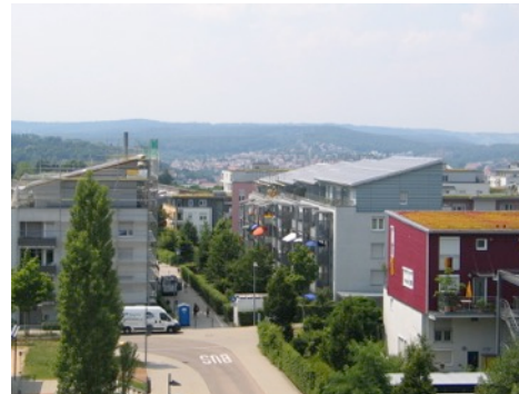
Anlage in Stuttgart Burgholzhof (DE)
