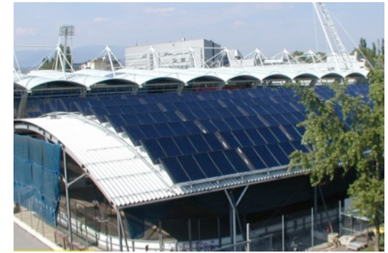
Anlage in Stadion Liebenau, Graz (AT)
