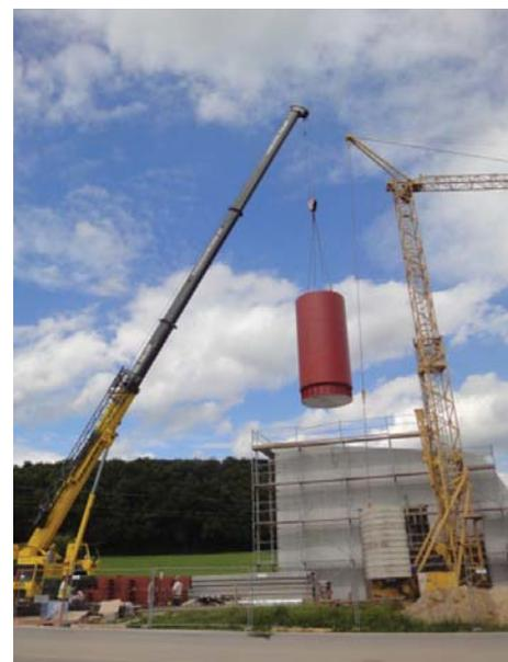
Einbau des Pufferspeichers per Kran
