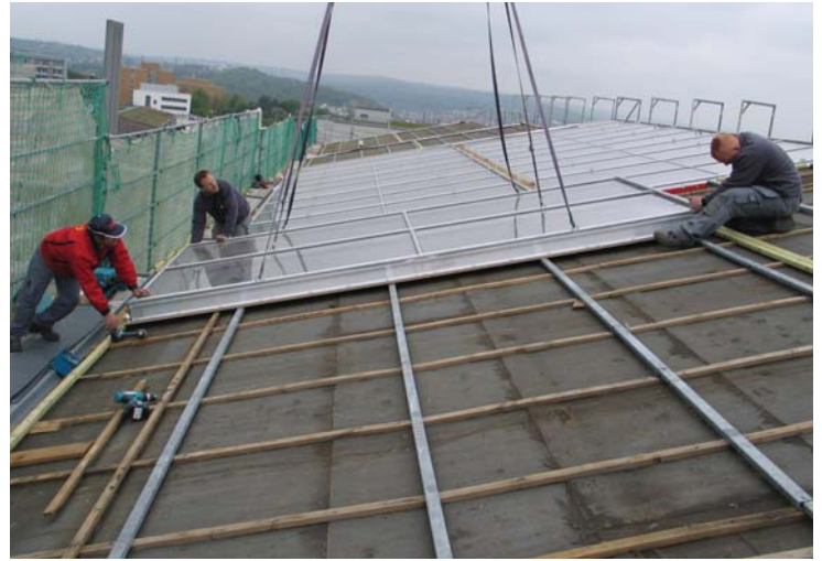
Montage der „Solar Roof“-Kollektoren
