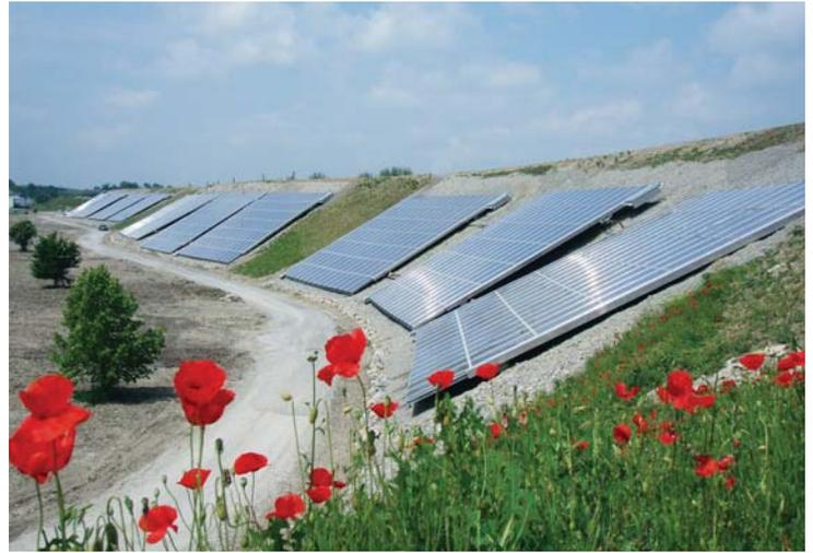
Solarkollektoren auf dem Lärmschutzwall
