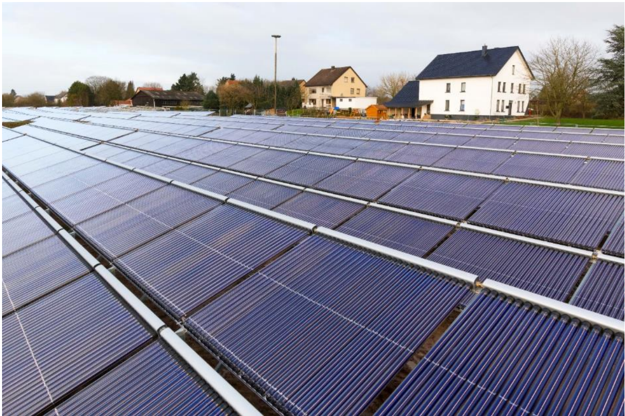
Bildzeile 2 (Foto): Solarthermie-Kollektoren beim iKWK-System der Stadtwerke Lemgo (Foto: Guido Bröer)
