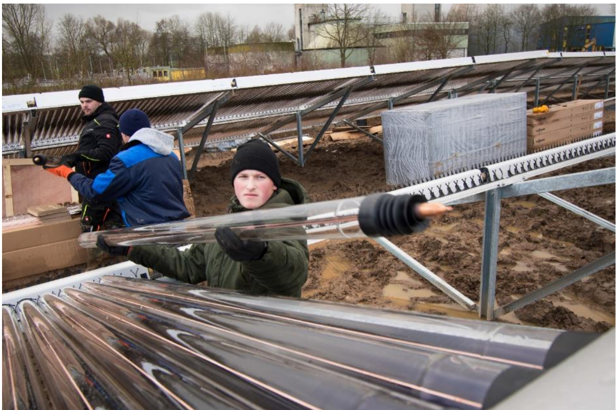
Bildzeile 3 (Foto): Montage der Vakuumröhren einer Freiflächen-Solarthermieranlage bei den Stadtwerken Lemgo (Foto: Guido Bröer)
